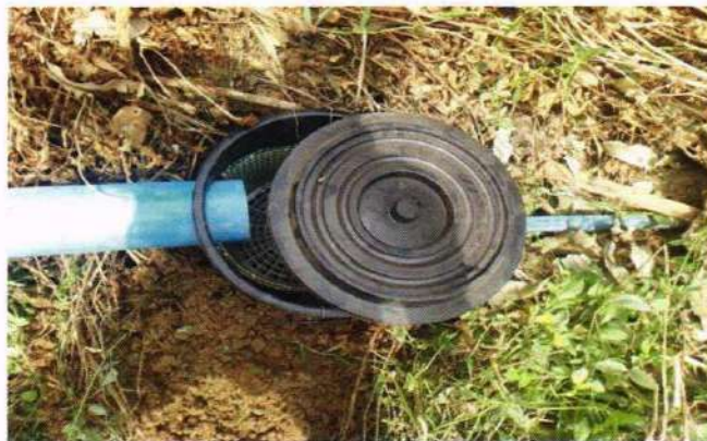
๓.ภาพการดำเนินการติดตั้งปอดักไขมันขององค์การบริหารส่วนตำบลภูคา
